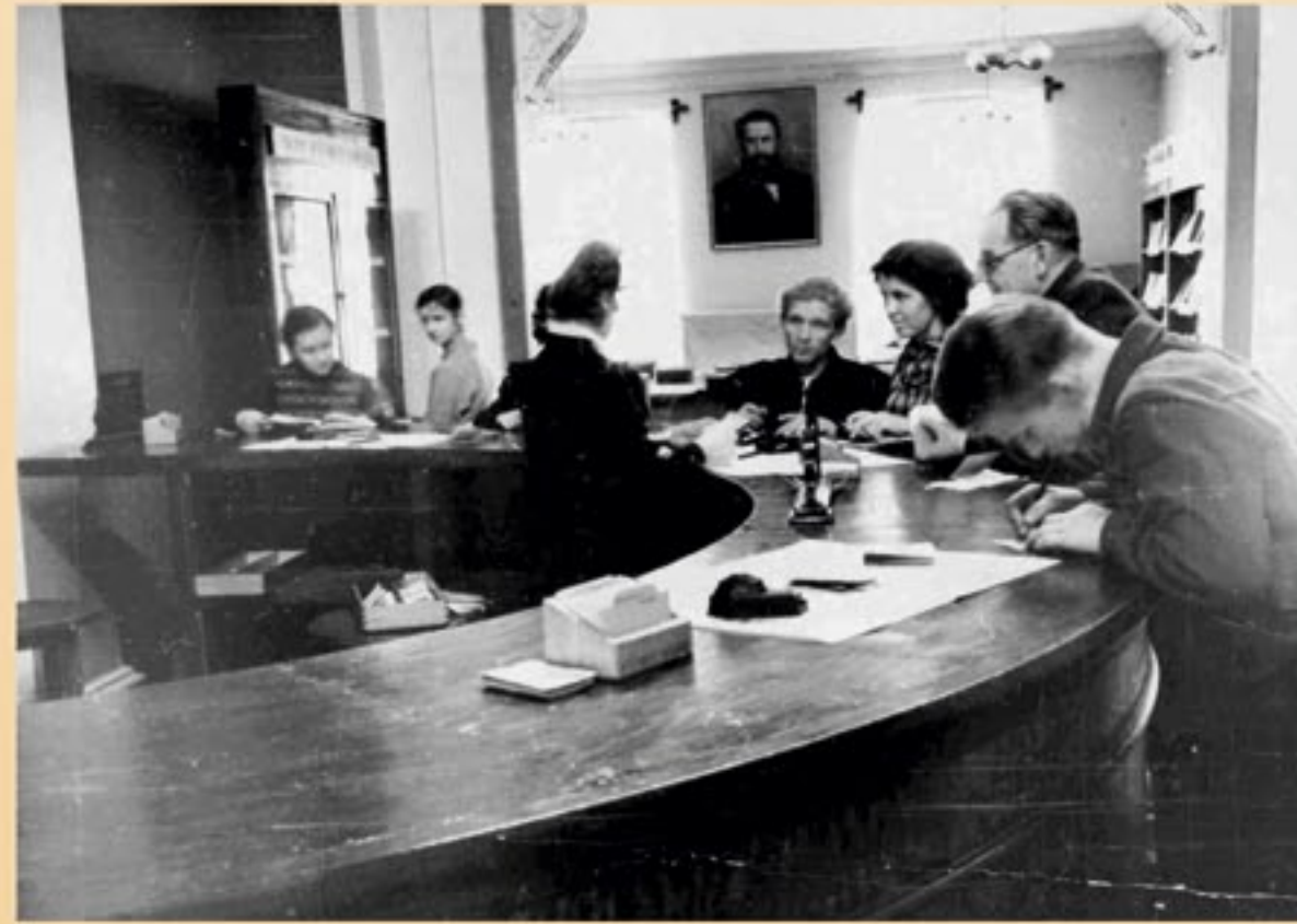
Кабина выдачи литературы (зал 2-го этажа)
